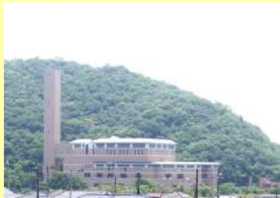
新緑とはだのクリーンセンター
