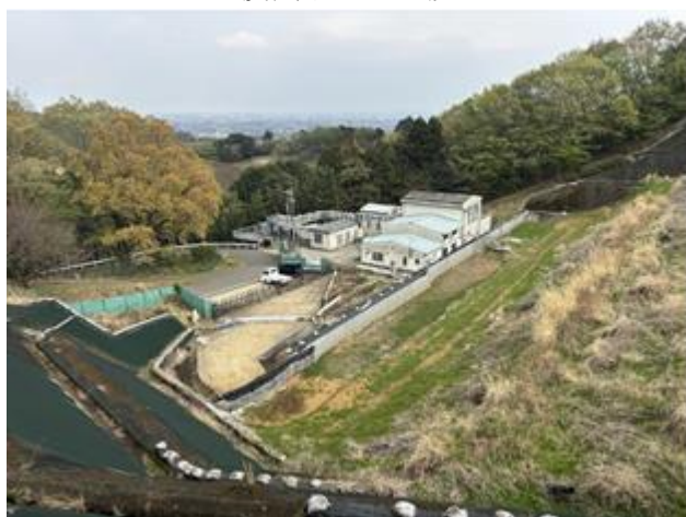
浸出水処理施設
