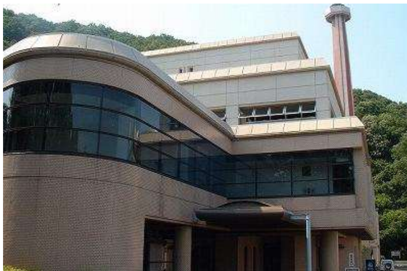
90t/日焼却施設
