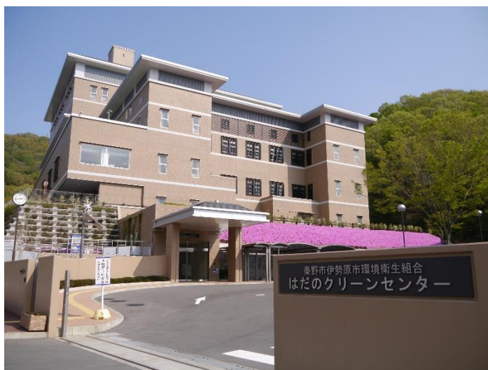
はだのクリーンセンター
