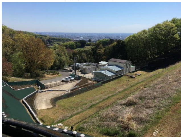
浸出水処理施設
