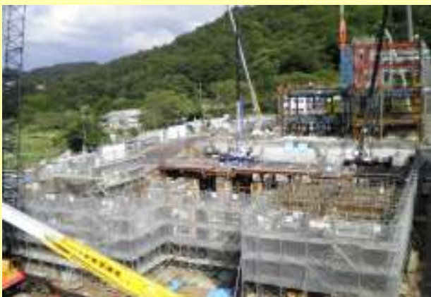
クリーンセンター建設工事現場の様子(平成23年9月)
