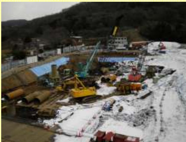
雪のクリーンセンター建設工事現場の様子(平成23年1月)
