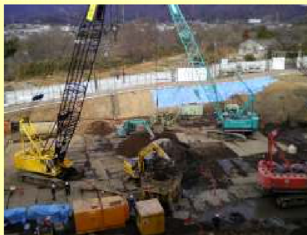
クリーンセンター建設工事現場の様子(平成23年1月)
